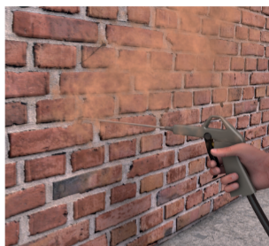
2 Reinigen van de boorgaten
